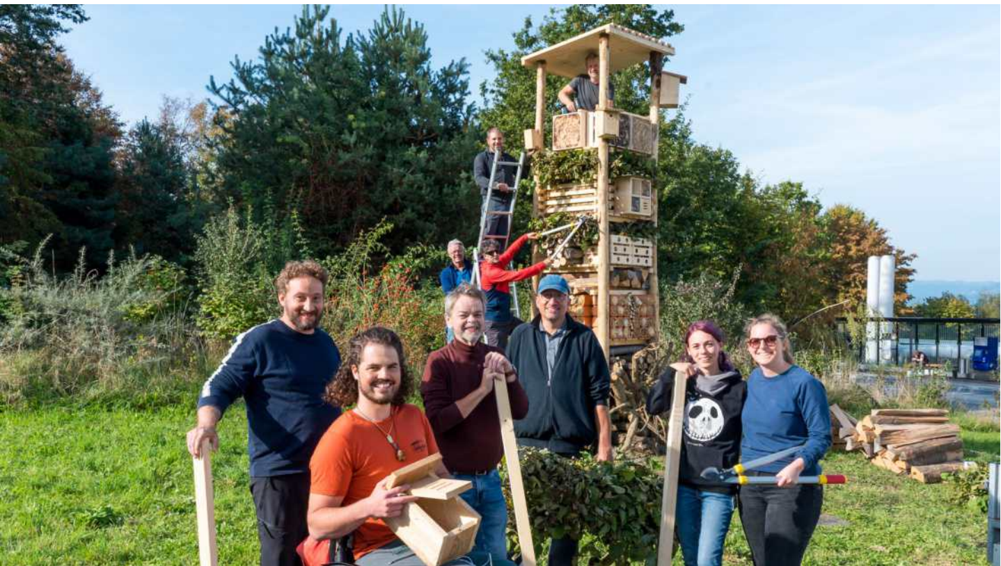
Ein Team aus Mitarbeitenden des Archehofs Hildisrieden, der Gärtnerei des Schweizer Paraplegiker-Zentrums und aus Klientinnen und Klienten der ParaWork baut den Lebensturm.
